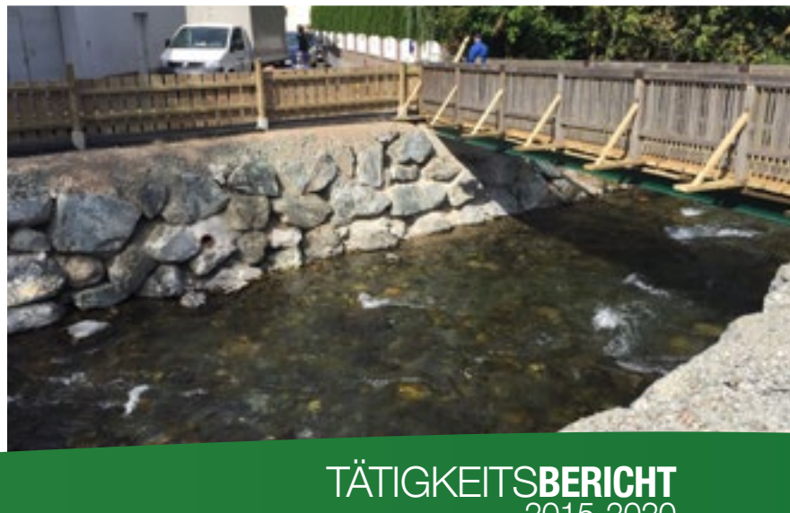
Ufersicherung im Bereich Mühlgraben
