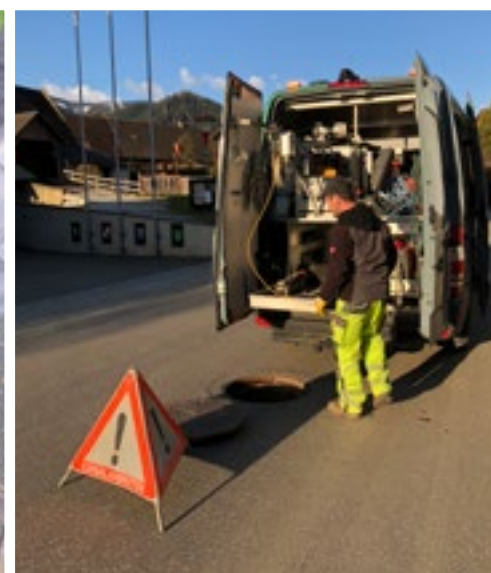
Kamerabefahrung der Kanäle für Zustandsbewertung
