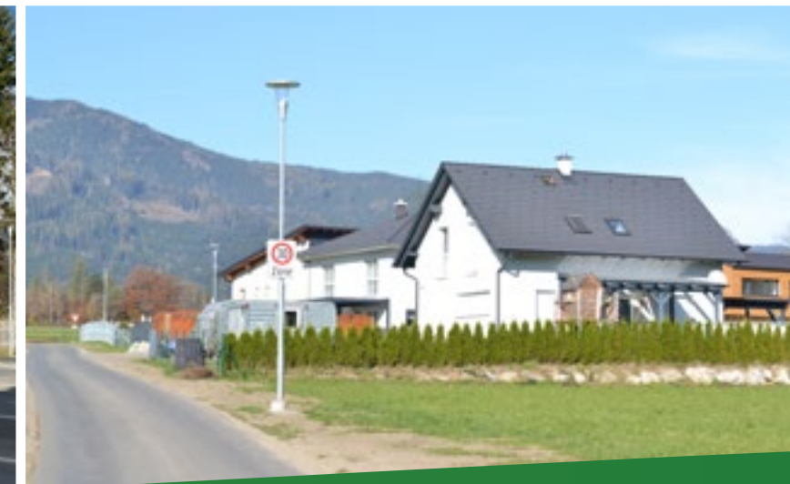
Straßenbeleuchtung am Friedenweg
