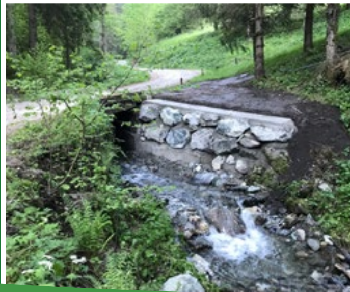
Brückensanierung in der Leims
