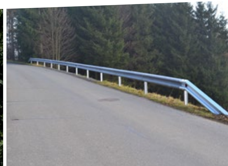
Holzleitschienen durch Metallleitschienen ersetzt
