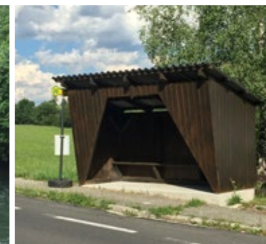
Neues Buswartehäuschen - Veitschersiedlung
