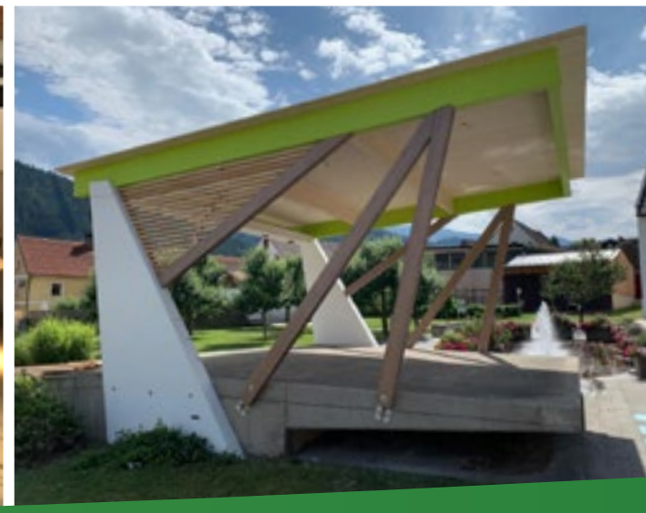
Neue Überdachung der Bühne am Marktplatz
