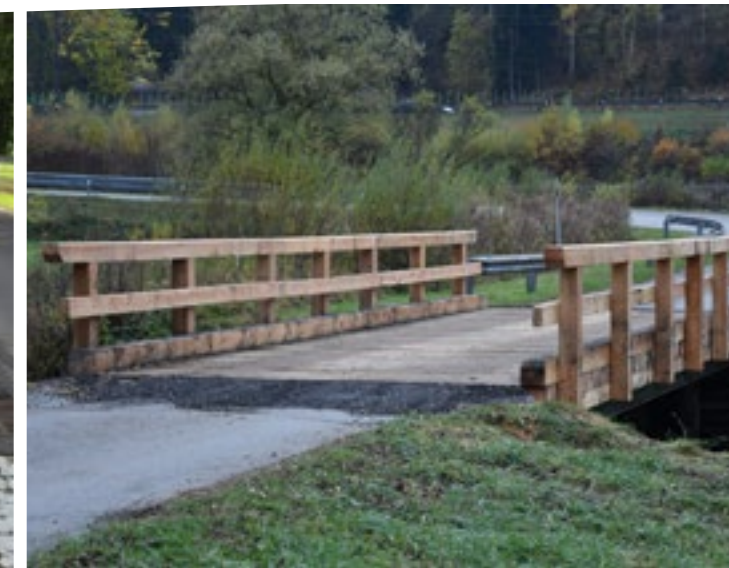
Sanierung Liesingbrücke - Zufahrt Fadelgraben
