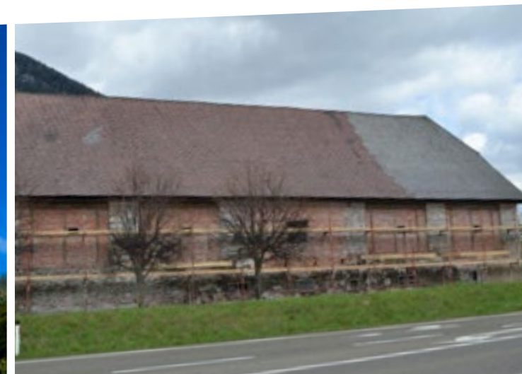
Sanierung des Pfarrstadels in Zusammenarbeit mit dem Stift Admont
