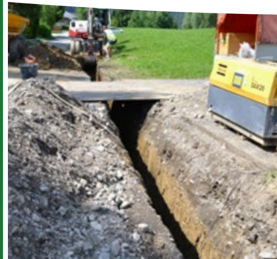
Sanierung und Erweiterung der Wasserversorgungsanlage
