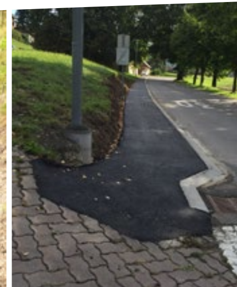
Gehsteigerrichtung - Hauptstraße Einfahrt Kammern
