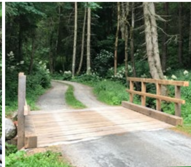
Brückensanierung mit Geländer im Fadelgraben
