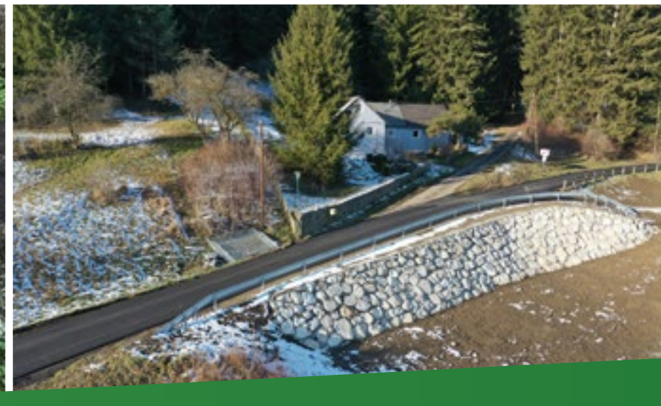
Steinschlichtung am Kalvarienbergweg
