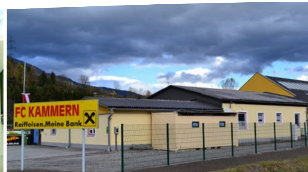
Sanierung der Fassade und Umzäunung sowie Ausbau einer Dachgeschoßwohnung zur zukünftigen Nutzung als Vereinslokal der Jägerschaft
