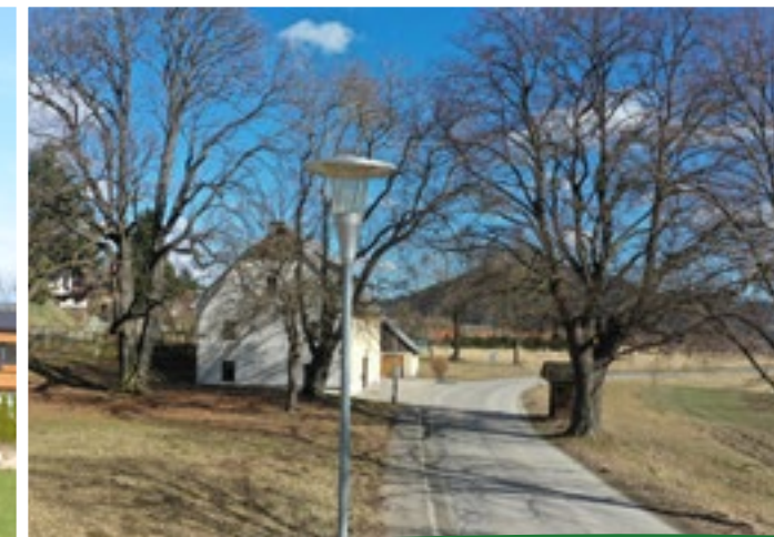
Straßenbeleuchtung Erweiterung - Hauptstraße bei Gasteiner
