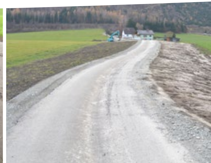
Straßenverbreiterung in Pfaffendorf
