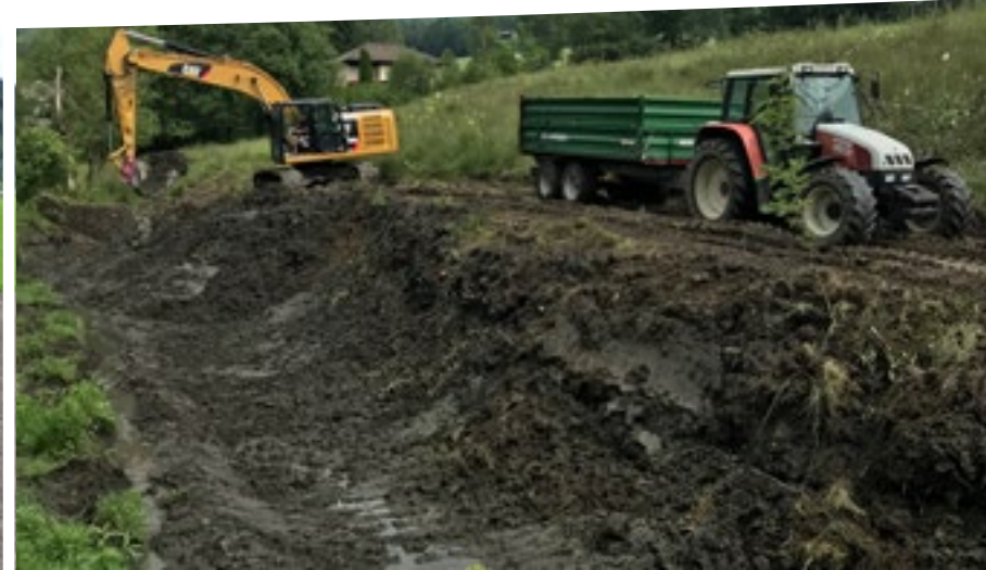
Sanierung des Löschteiches in Mochl
