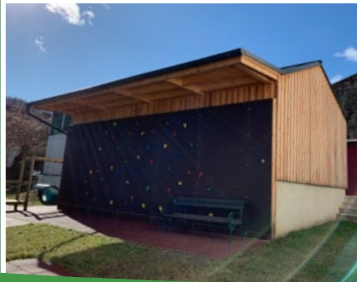
Bau eines Lagers mit Kletterwand
