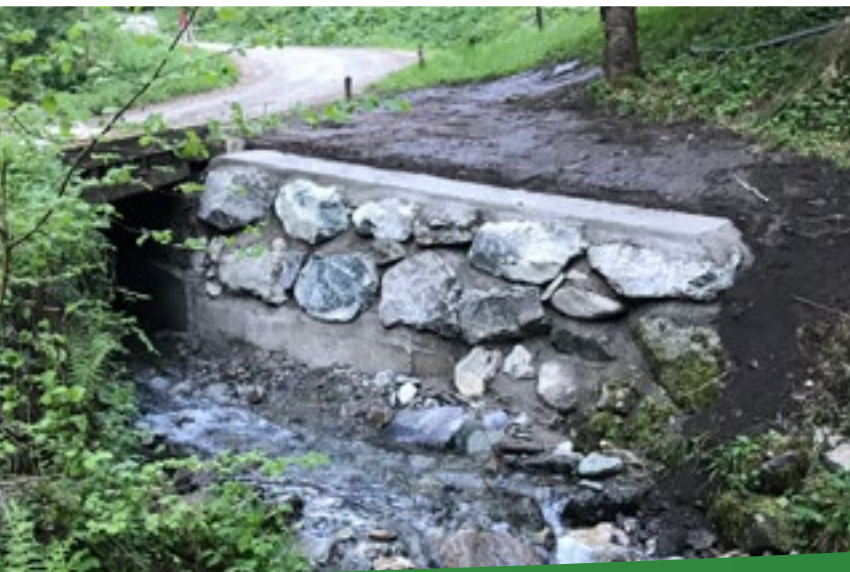
Steinschlichtung Brücke Leims
