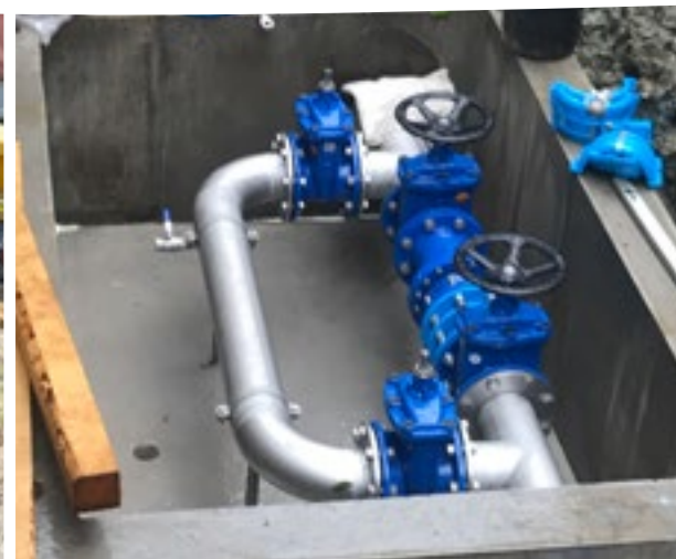
Erneuerung der Pumpstation - Karl im Hofweg
