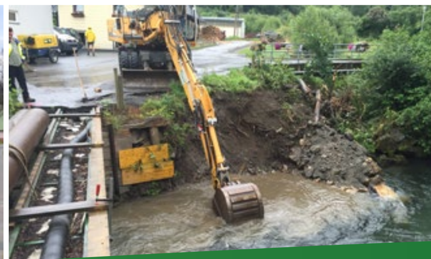
Querung der Liesing mittels Düker
