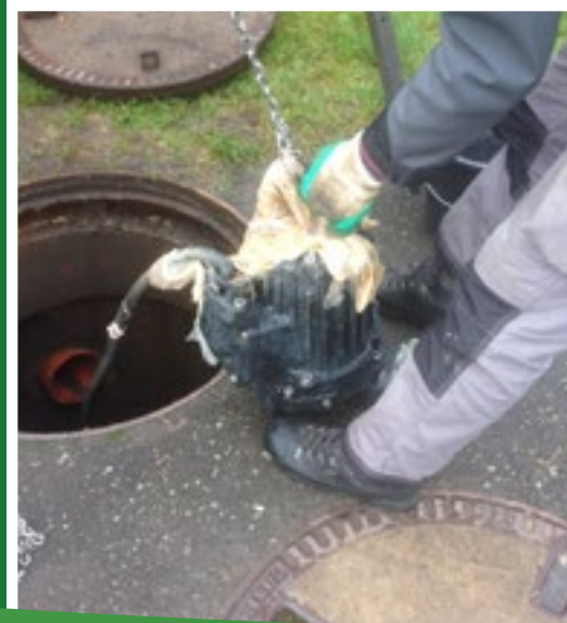
Erneuerung mehrerer Kanalpumpwerke
