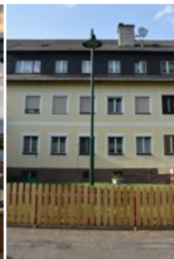
Zaun und Beleuchtung für Parkplatz beim Heimatsaal
