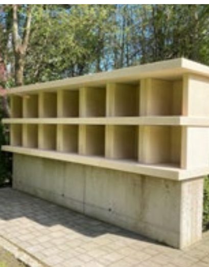
14 neue Urnenwandnischen am neuen Friedhof
