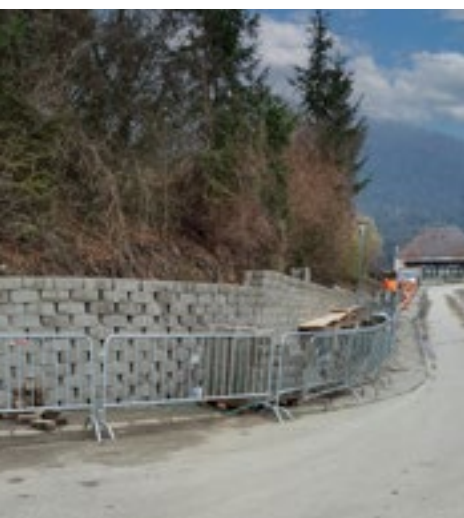
Erneuerung der Steinmauer im Mühlgraben
