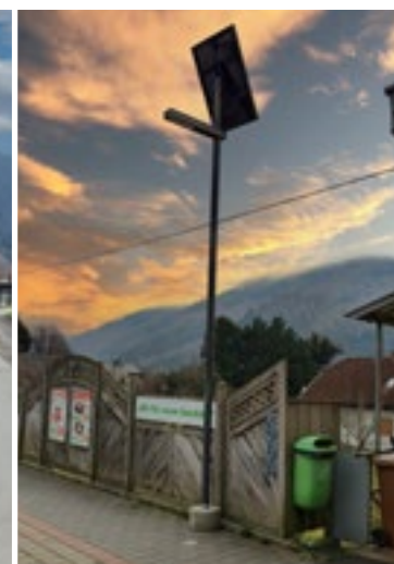
Parkplatzbeleuchtung beim Geschäft
