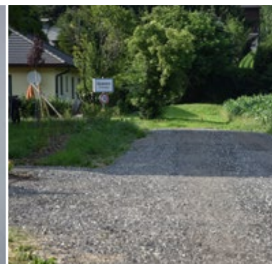
Zufahrt in der Jägersgasse zu den neu errichteten Wohnobjekten
