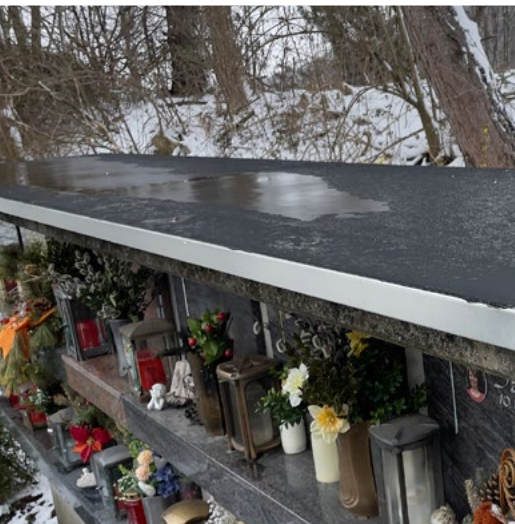
Dachabdeckung der Urnennischenwände
