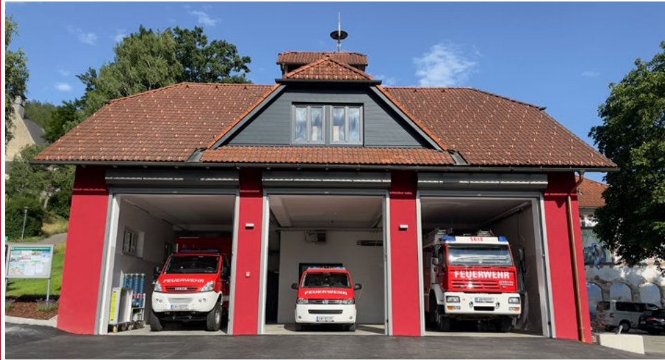
Fertigstellung der Generalsanierung und Erweiterung des Rüsthauses Seiz
