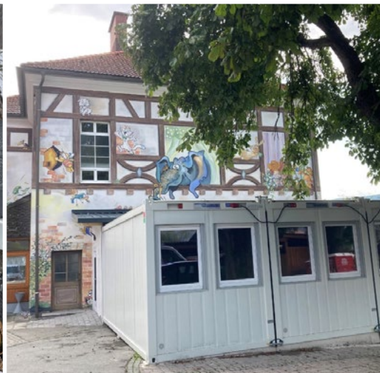
Provisorium für Kindergartenausbau mit Kinderkrippe
