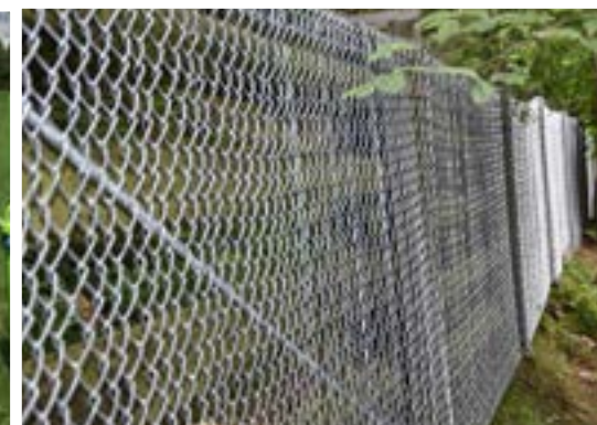
Steinschlagschutz bei der Gamswand erneuert
