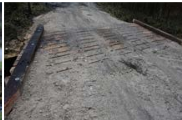
Vollständige Sanierung einer Brücke in der Leims
