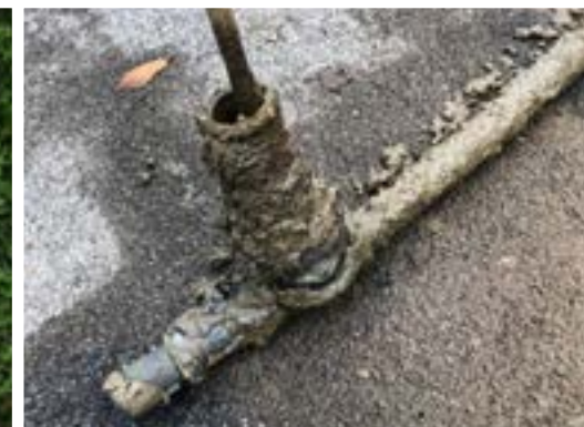
Wasserleitungsbau Kalvarienbergweg/Karl im Hofweg (so sah die Leitung vorher aus)
