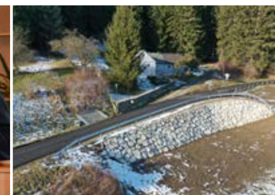
Steinschlichtung am Kalvarienbergweg
