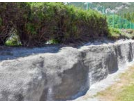
Steinschlichtung beim Sportplatz errichtet
