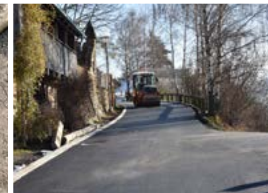
Asphaltierung des Kalvarienbergweges
