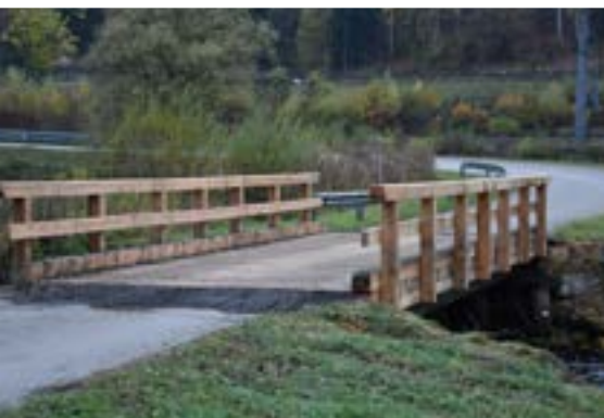
Ernerung der Brücke über die Liesing zum Fadelgraben
