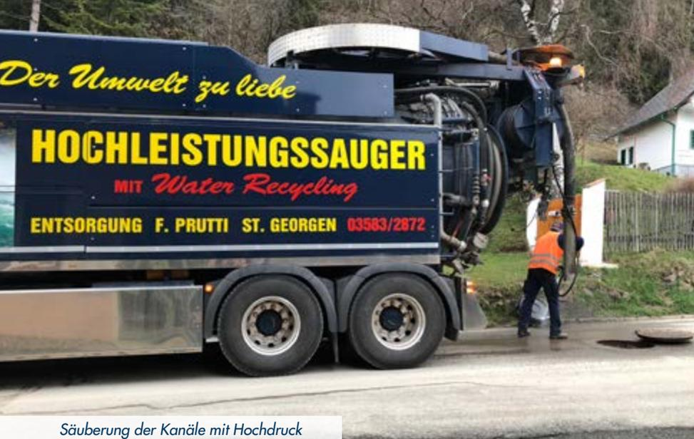
Säuberung der Kanäle mit Hochdruck
