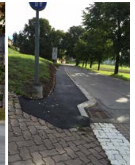
Gehsteig und Beleuchtung zur Bushaltestelle
