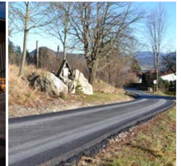
Oberflächenentwässerung und Asphaltierung – Karl im Hof
