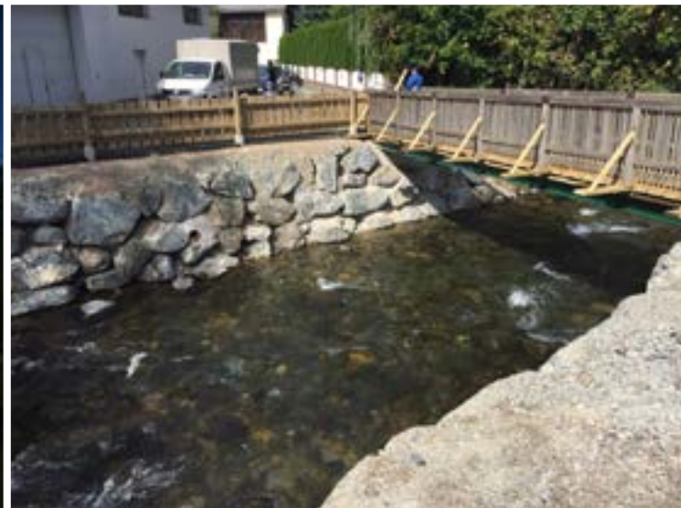
Sanierung der Uferböschung, Bachquerung und Stegerneuerung im Mühlgraben
