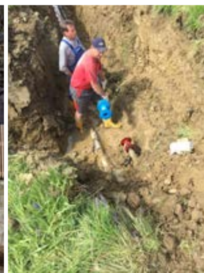
Sanierung der Trinkwasserleitung
