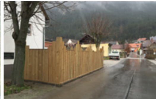
Neue Müllstation in der Kirchgasse € 2.000,-
