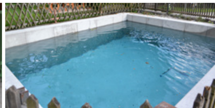
Sanierung des Löschteiches € 17.000,-
