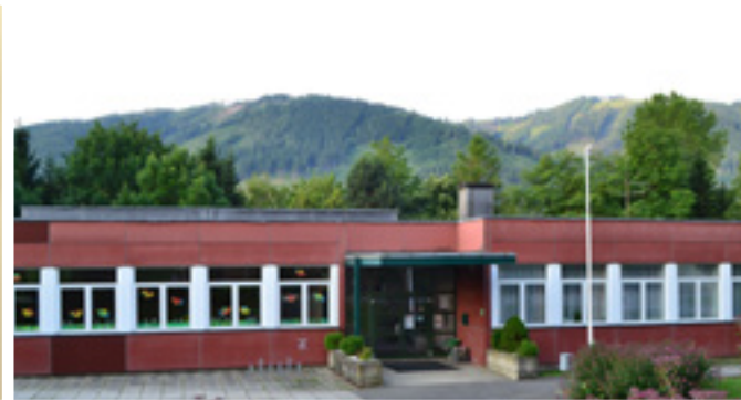
Sanierung der Volksschule inklusive Heizung € 150.000,-
