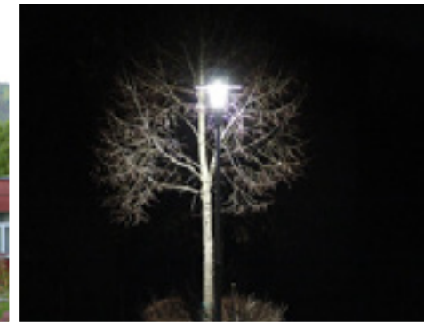
LED Beleuchtung- Umstellung u. Erweiterung € 110.000,-
