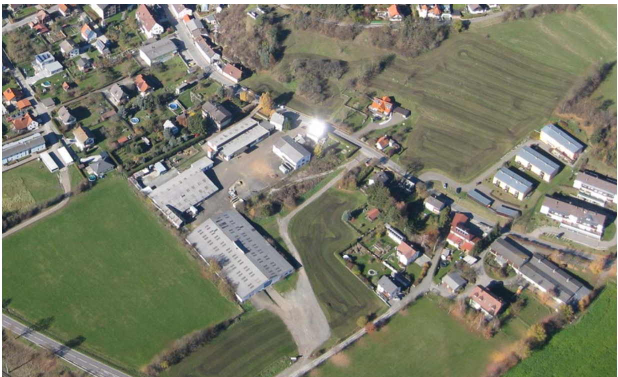
Ansicht von Südosten, 2015
